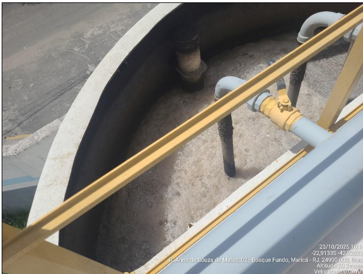
Figura 4.24 - Formação de espuma no reator MBBR. Fonte: Acervo da Equipe.
